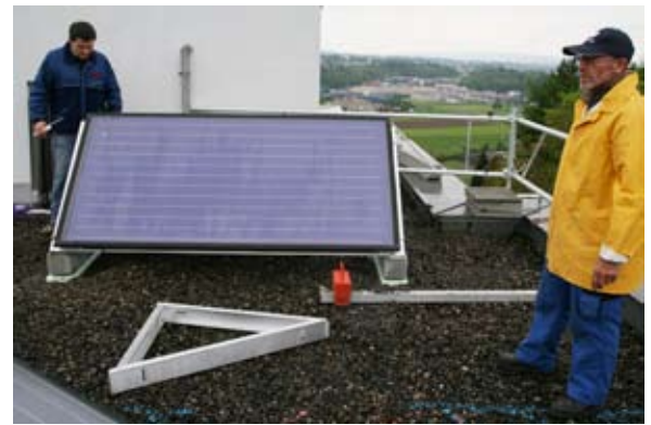
Montage des 1. Solarpanels
