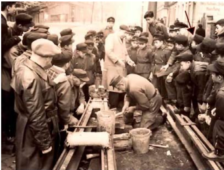
Dresden 1958. Klassenbesuch einer Strassenbahnfabrik. Vorführung des Schienenschweissens mit dem Thermit-Verfahren
